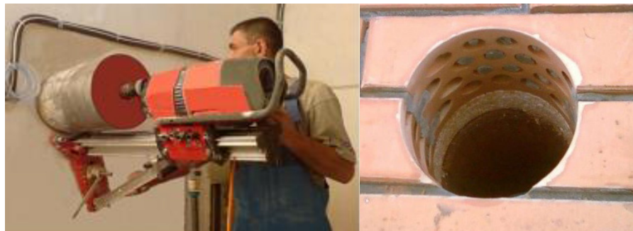
Рис. 4. Выработка монтажного отверстия в стене на фасаде эксплуатируемого дома
