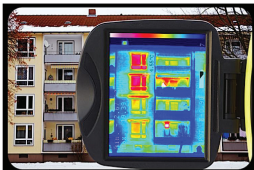
Рис. 1. Характерный случай некачественного регулирования системы отопления
